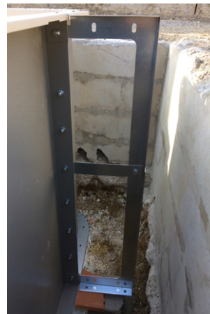
Structure d'une piscine Aquilus avec jambes de force « échelle »
