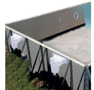
Structure d'une piscine Aquilus avec jambes de force classiques
